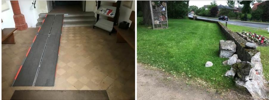
Bild links: provisorische Rampe im Eingangsvorraum, rechts: marode Einfriedung
